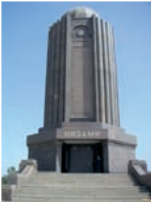
Nizami Gändžävi monument Gändžäs
